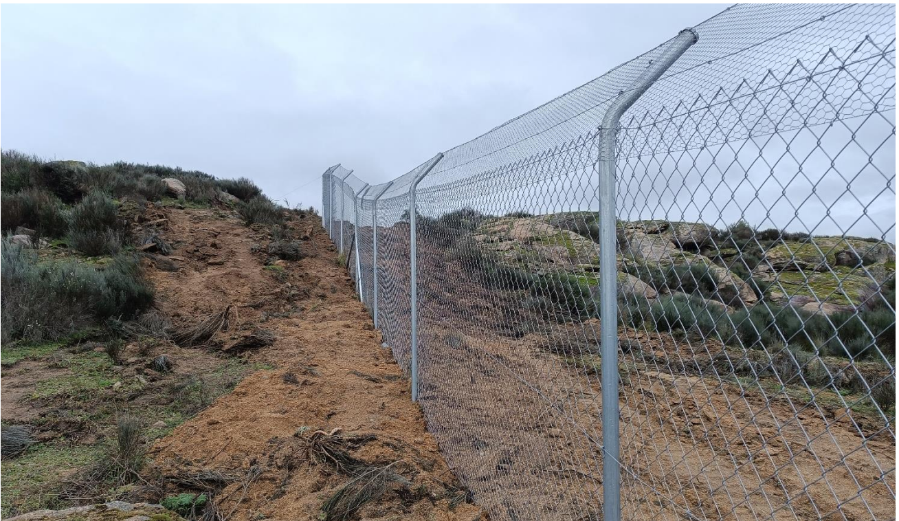
Fig. 5. Vedação (com pescoço de cavalo) que delimita o Campo de Alimentação para Aves Necrófagas localizado em frente à jaula de aclimação para soft-release de abutres-pretos construída em Fornos, Douro Internacional, no âmbito do projeto LIFE Aegyptius Return. ©Palombar
