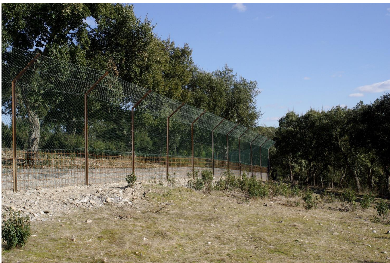
Fig. 1. Pormenor da vedação do Campo de Alimentação para Aves Necrófagas localizado na Herdade da Contenda, Moura (Portugal). ©LPN
