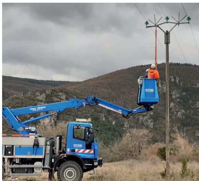
Sécurisation de lignes électriques © Laurence Galabrun ENEDIS
